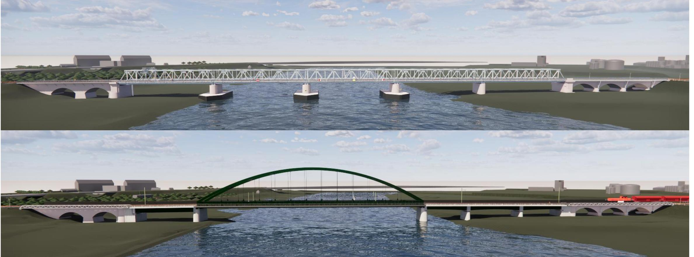
Die Anpassung der Brücken, insbesondere der Brücken über die Donau stellen eine besondere Herausforderung dar. Wir erstellen Planungen mittels Building Information Modeling (BIM). Im Bild die Donaubrücke Regensburg-Schnabelweis im Bestand (oben) und nach dem Ausbau (unten).
